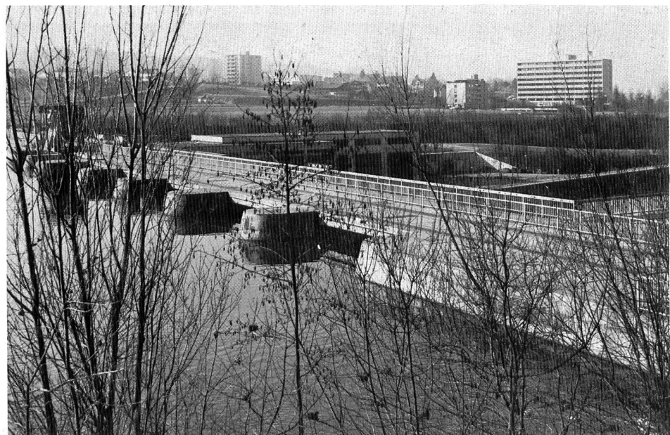
Bild 12. Reusskraftwerk Bremgarten-Zufikon. Das Wehr, das Maschinenhaus und die Schaltanlage wurden sorgfältig in die Landschaft eingepasst. Die gleichzeitig und anschliessend erstellten Hochbauten stören das Landschaftsbild wesentlich mehr (Bild VAW, Februar 1982).
