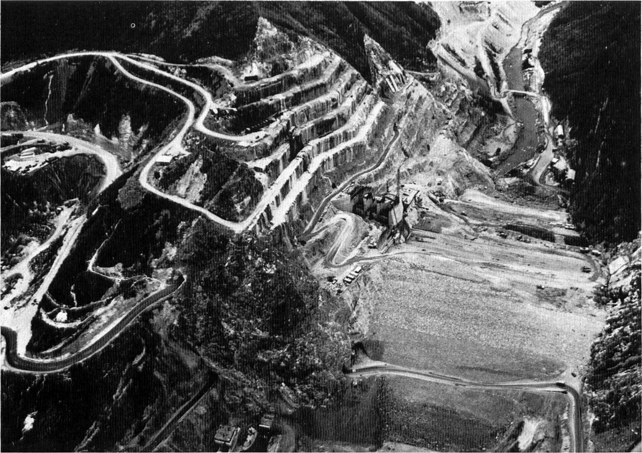
Bild 4. Die Dammbaustelle am 21. Januar 1982; der 130 m hohe Steinschüttdamm mit geneigtem Dichtungskern, Flussumleitung und Hochwasserentlastungsanlage an der linken Talflanke; an der Sperrstelle liegt verkarsteter Kalk auf kristallinen Gesteinen (Serpentin); vulkanische Asche bedeckt die Hänge im Stauraum. Speichervolumen des Stauraums: 460 Mio m 3 ; installierte elektrische Leistung: 300 MW; jährliche Energieproduktion: etwa 1700 GWh.
