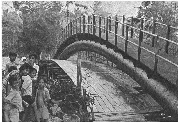
Bild 4. Flussüberquerung der Transportleitung als Rohrbogenbrücke mit aufgesetztem Fussgängersteig ausgebildet.
