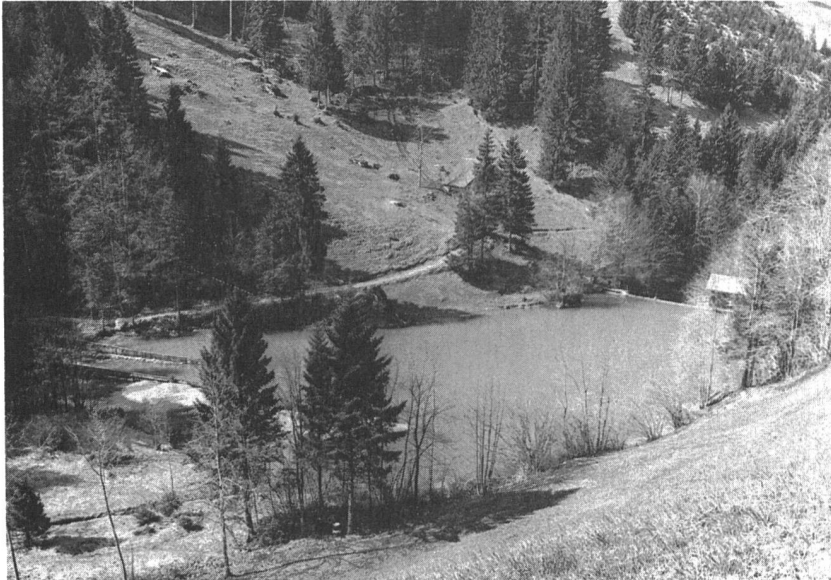
Bild 2, links. Das Ausgleichsbecken Käppelistutz, rechts die bestehende Stau-mauer.
