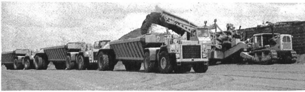
Bild 6. Holland-Loader beim Abbau des Kernmaterials. Der auf zwei Rampenfahrzeugen (D9) sitzende Loader schält das Material von der 3,5 m hohen vertikalen Abbaufont (Hintergrund) und fördert es in die Transportfahrzeuge. Das Beladen eines 70-t-Transporters dauert etwa eine Minute.
