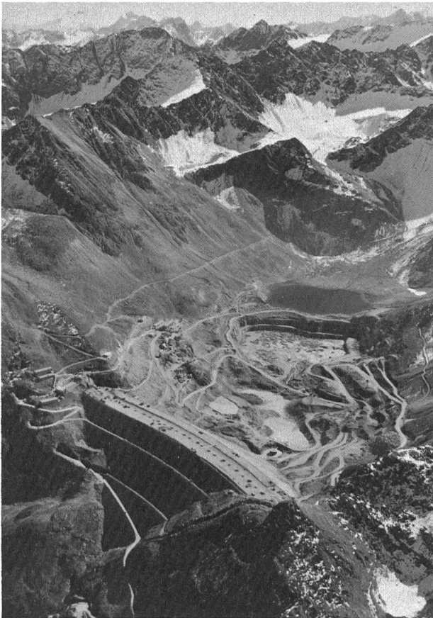
Bild 1. Staudamm für den Speicher Finstertal (60 Mio m 3 ) in 2325 m NN. Ende 1979.
