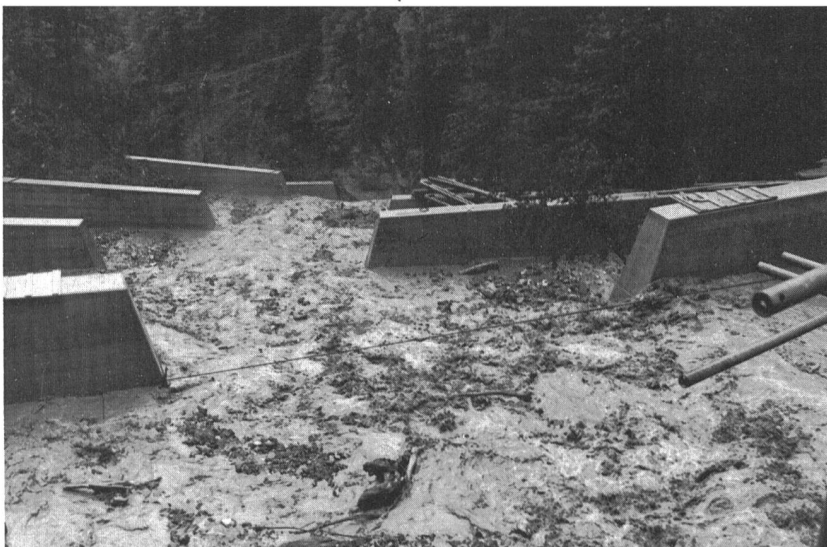
Bild 2, rechts. Der Durnagelbach im Kanton Glarus ist ein gefährlicher Wildbach. Seit den grossen Verwüstungen im Jahre 1944 wird sein Lauf systematisch verbaut. Das Bild zeigt die fünf kürzlich fertiggestellten Sperren Nr. 7 bis 11 bachabwärts gesehen. Ein sehr starker Murgang hat diese Sperren bereits wieder hinterfüllt. Auch mit grossem Aufwand und starken Konstruktionen ist es nicht einfach, die Naturgewalten im Durnachtal auch nur einigermassen zu bewältigen.
