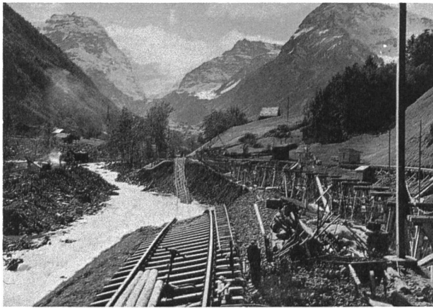
Bild 3. Die Eisenbahnverbindung mit Linthal wurde durch den Durnagel für 54 Tage unterbrochen. Eine Bauabteilung der SBB errichtet eine Notbrücke.
