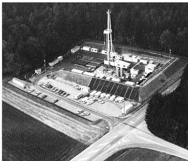
Bild 1. Das Bohrgelände Böttstein. In der Bildmitte steht der 44 m hohe Bohrturm, rechts davon schliesst die Maschinenplattform an, auf der die elektrischen Antriebsorgane untergebracht sind. Links am Bildrand – in einem umgebauten Schiffscontainer – die ständige Informationsausstellung der Nagra, die täglich von 13 bis 17 Uhr besucht werden kann.
