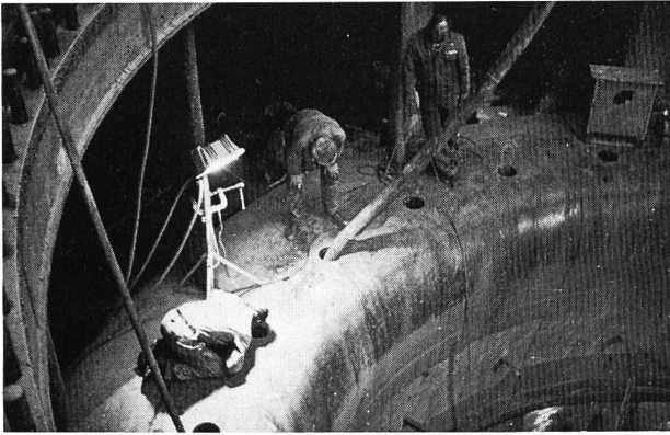
Bild 1. Blick von Osten in den Einlauf der Turbine 3 des Kraftwerkes Ryburg-Schwörstadt. Von oben wird der etwa zentrisch aufgehängte Pumpenschlauch in die einzelnen Füllöffnungen, in denen die Leitschauellager eingesetzt werden, eingeführt und der Beton in den Hohlraum hinter den Laufradmantel eingefüllt.
