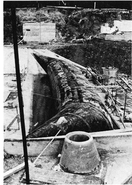
Bild 3. Schlauchwehr in der Rhone bei Visp. Probefüllung eines Schlauches in trockener Baugrube 1972 (Fließrichtung der Rhone von rechts nach links). Foto Jules Maurer, Renens [1].
