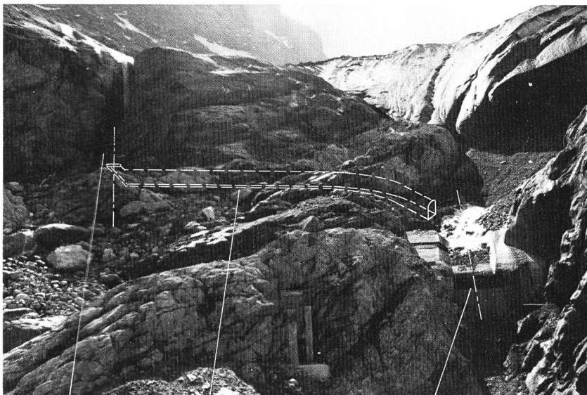
Bild 3. Am rechten Bildrand das Einlaufbauwerk der Wasserfassung Bifertenbach II. Darüber die Gletscherzunge des Bifertenfirns. Seit dem Zeitpunkt der Aufnahme dieser Photo (1978) ist der Bifertengletscher weiter vorgestossen und hat das Einlaufbauwerk vollständig überfahren.
