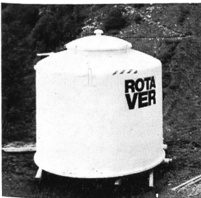
Trinkwasser-Reservoir für Hotel im Hochgebirge
