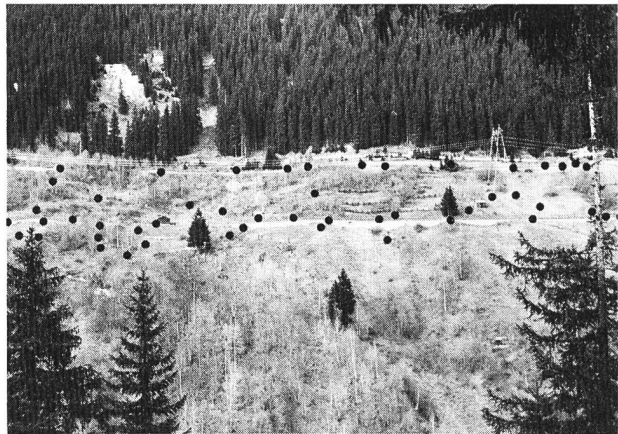
Bild 2. Ausschnitt aus der Messanlage Sedrun, vom Gegenhang aus gesehen. Die Kontrollpunkte sind mit schwarzen Tupfen markiert.
