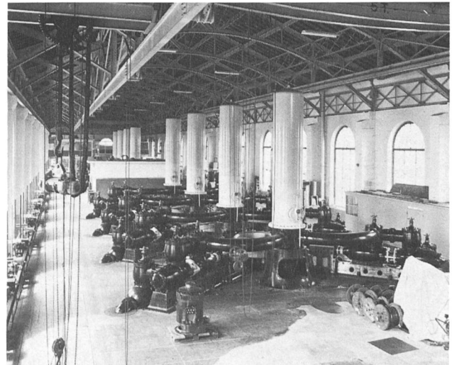
Bild 1. Ansicht auf einige Pumpen-Aggregate des Pionier-Pumpwerks «La Coulouvrenière» der Stadt Genf.
