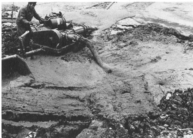
Bild 1. Diesel-Pumpaggregat Wangen 100 ST im harten Einsatz bei der Entleerung von Kiesschlamm-Becken.
