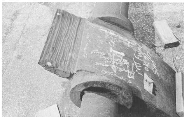
Bild 8. Auftragsschweissung an einer Leitschaufel. Das Bild vermittelt eine Vorstellung davon, wie langwierig solche Reparaturschweissungen sind. Man hat sich denn auch entschlossen, nach und nach die Leitschaufeln durch solche aus rostfreiem Stahl zu ersetzen (siehe Bild 9).
