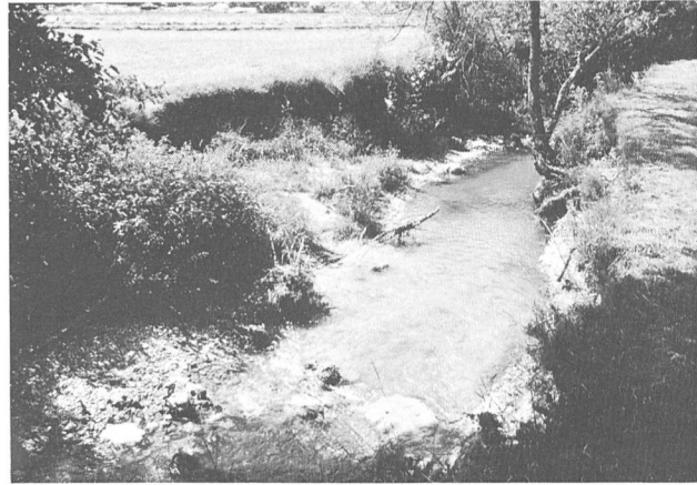
Figure 2. «Auto-colmatage» de la berge après entretien. Excepté l'enlèvement de l'obstacle illustré par la figure 1, rien n'a été entrepris. Alle (JU) 29.7.1981.
