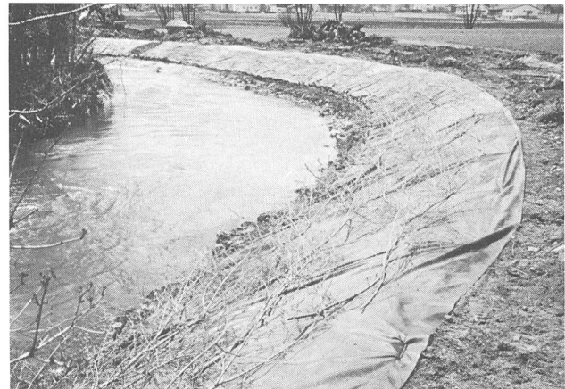
Figure 9. Des branches de 4 espèces de saules sont cousues sur le géotextile pour maintenir la terre de surface et fixer le textile. 28.4.82
