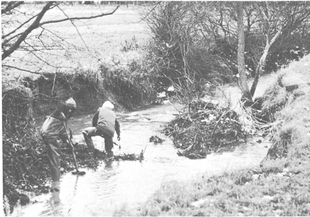
Figure 1. Une souche au milieu du lit a accumulé beaucoup d'embâcles, divisant le courant en deux branches. Cette séparation a pour effet de saper les deux rives. Alle (JU) 15.11.1980.
