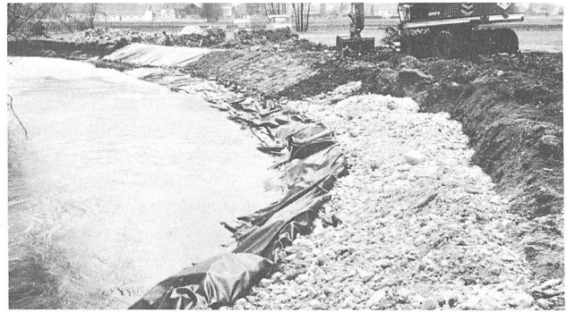
Figure 8. Détail de remplissage du géotextile. 27.4.82.
