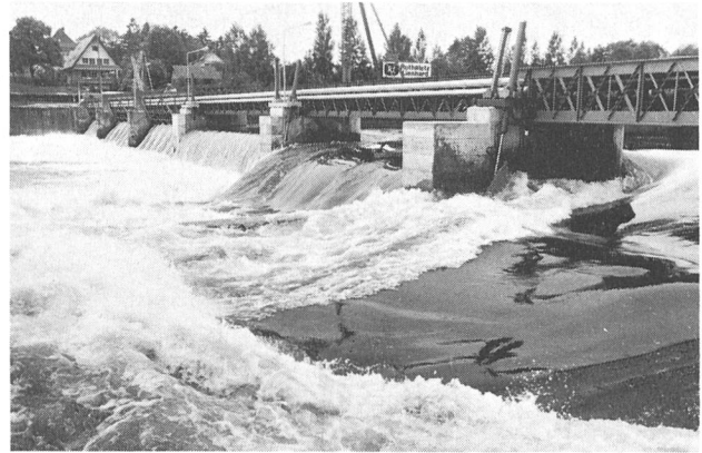
Bild 1. Ansicht des umgebauten Wehres von der Unterwasserseite her. Im Vordergrund die drei hydraulisch betätigten Wehrklappen in unterschiedlicher Öffnungsstellung. Die drei Wehrröffnungen im Hintergrund besitzen nach wie vor die alte Schleusenausrüstung.
