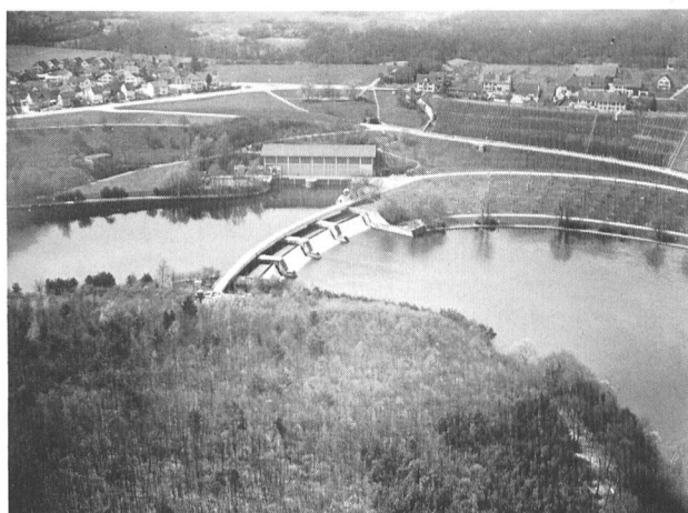
Bild 3. Stauwehr und Maschinenhaus des Kraftwerks Rheinau.
