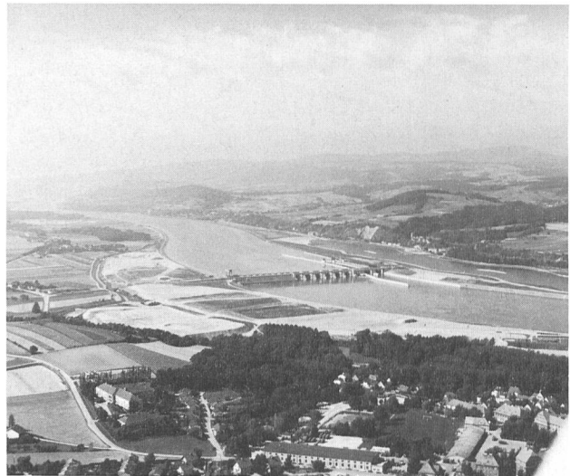
Bild 12. Donaukraftwerk Melk gut in die umgebende Landschaft eingepasst – Ende 1983.
