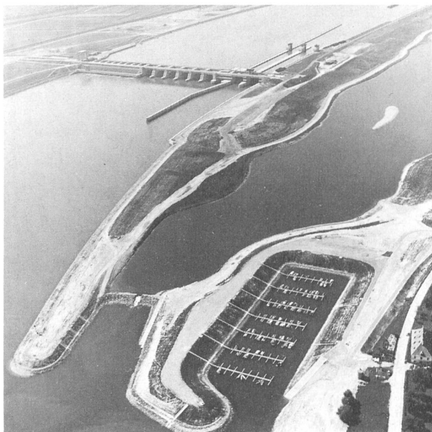
Bild 10. Staustufe mit Laufkraftwerk Melk mit Vorhäfen der Schleusenanlage und Bootshafen im Altarm der Donau (September 1983).
