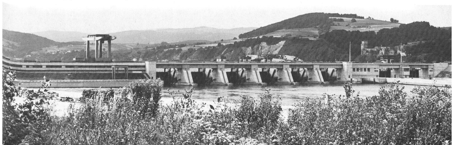
Bild 1. Blick auf das Donaukraftwerk Melk vom Unterwasser (rechtes Donauufer) aus. Die Verwendung von Rohrturbinen ermöglicht eine niedrige, der Landschaft angepasste Bauausführung des Hauptbauwerks.
