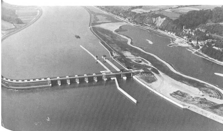
Bild 6. Laufkraftwerk (links), Wehr- und Schleusenanlage (Mitte) und rekultivierter Altarm der Donau Ende September 1983.
