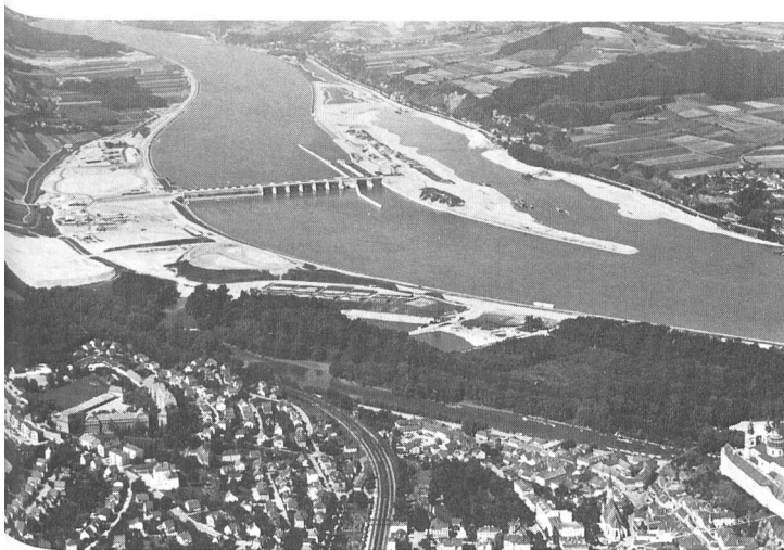
Bild 5. Donaukraftwerk nach Vollenbetriebnahme Mitte August 1982 und Beginn der Rekultivierungsarbeiten am Altarm des Stroms (rechts vom Hauptbauwerk); der Auwald unterhalb des Stiftsfelsens blieb von den Bauarbeiten unberührt.
