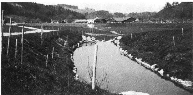
Bild 6. Das Rückhaltebecken mit Kiesfang, Blick Richtung Chälhof.
