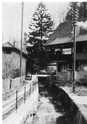
Bild 3. Der Chatzenbach im Dorf Turbenthal. Ein Ausbau konnte dank des Rückhaltebeckens vermieden werden.
