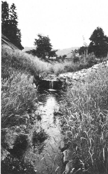
Bild 11. Der Bachausbau im Weiler Oberhofen.
