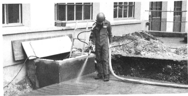
Applikation einer «Vatec»-Unterterrain-Flachdachabdichtung.
