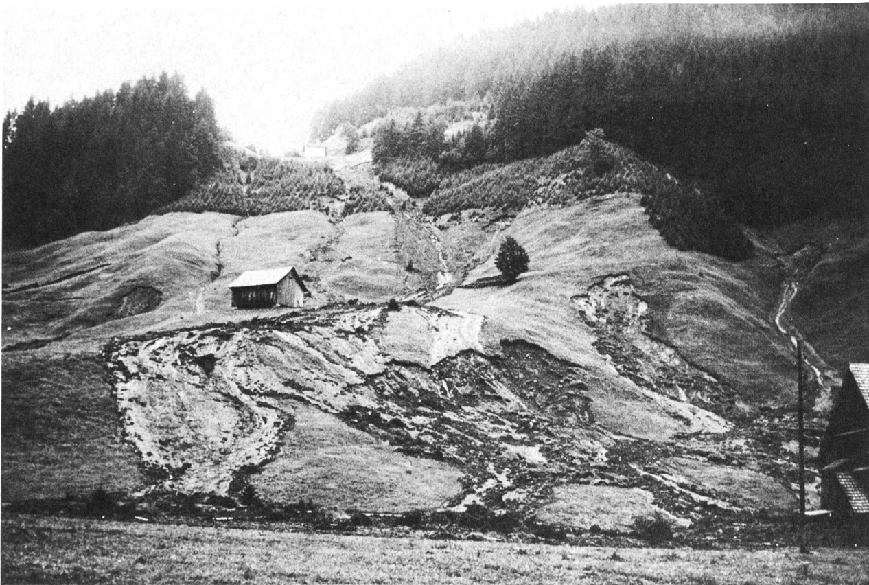
Bild 4. Typische Schäden im Landwirtschaftsgebiet talaufwärts der Ortschaft Alphthal. Hydraulische Grundbrüche lösten Rutschungen aus, welche kleine Murgänge abflossen. (Foto EAFV)
