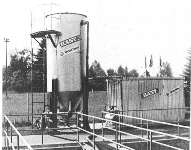
Bild 5. DynaSand-Filter als Einzelelement.
