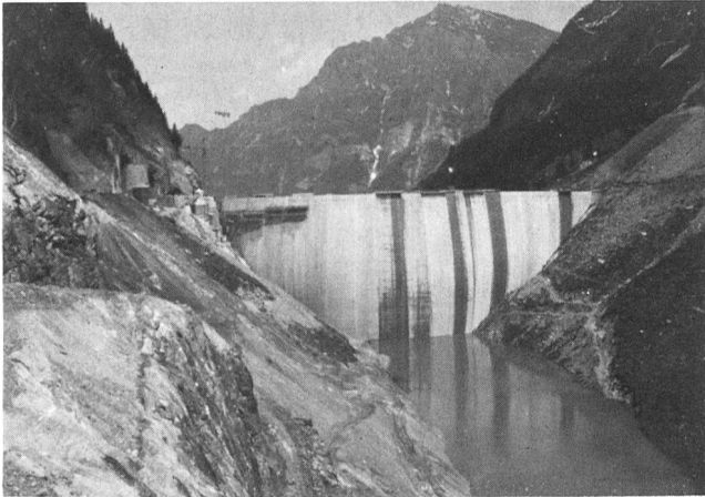
Barrage de Gigerwald, Suisse
