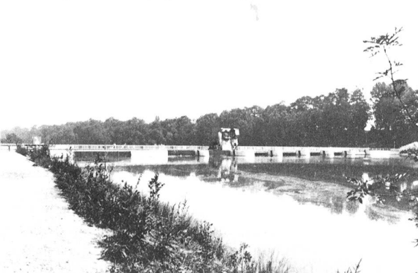
Bild 7. Reusskraftwerk Bremgarten-Zufikon, Inbetriebnahme 1975. Ma- schinenhaus (links) und Wehr (rechts) sind als solche kaum zu erkennen. Sie überragen den Stauspiegel nur wenig.
