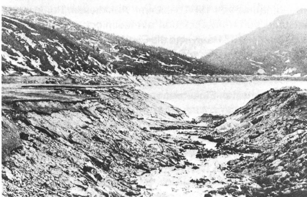
Bild 5. Erosionsrinne im Bachkegel des Tomsee-Abflusses im Ritomsee nach 9 Monaten Absenkung am 30. Juni 1917 (Foto C. Ghezzi, aus Collet et al., 1918).
