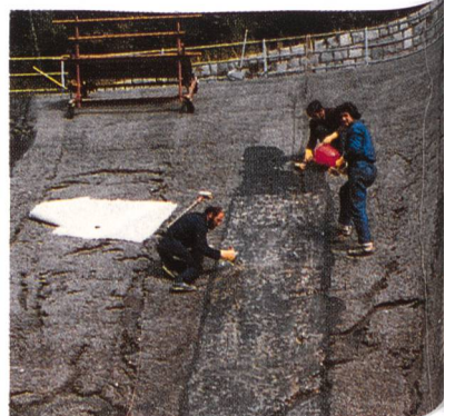
Abdichtungen für Ausgleichsbecken
