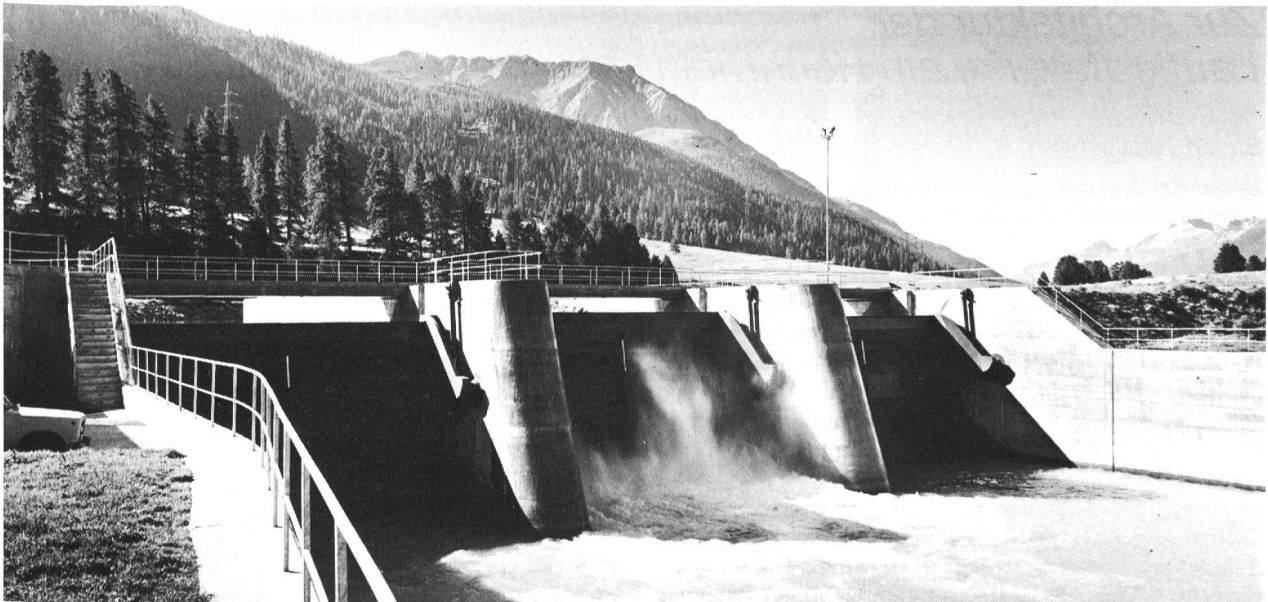
Das Wehr der Wasserfassung S-chanf der Engadiner Kraftwerke AG.
