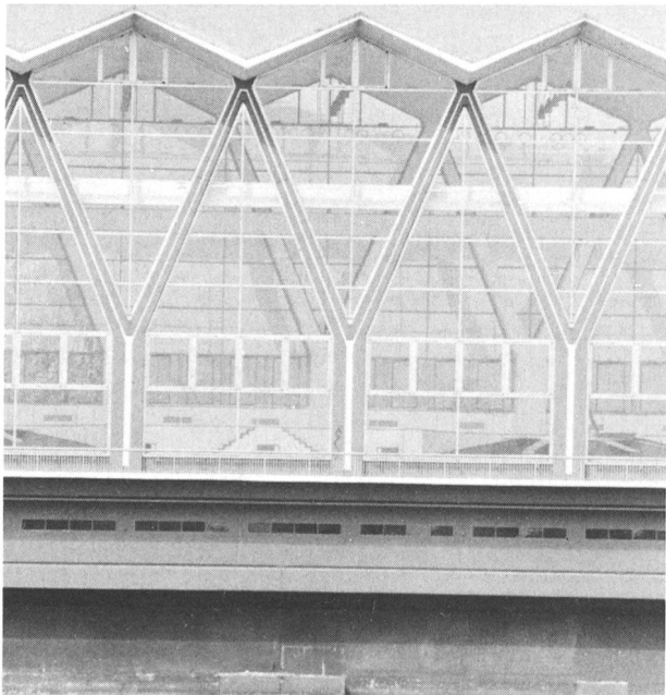
Bild 15. Eigenwillige Fassadengestaltung in Birsfelden.
