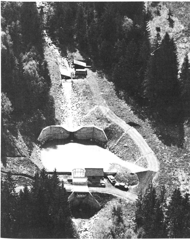
Bild 2. Messstation Erlentobel der EAFV im Alptal mit oberer Messstation, Schussrinne, Geschiebeauffangbecken und unterer Messstation mit V-Messüberfall (Einzugsgebiet 0,75 km 2 ), Bewaldungsgrad 39%, auffangbares Geschiebevolumen 2500 m 3 , Dimensionierungshochwasser 15 m 3 /s, überlastbar bis 25 m 3 /s bei einem Q 100 ≈ 12 m 3 /s). (Foto Militärluftdienst)
