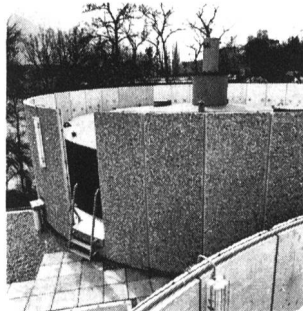
Faulanlage, Villetle, Genf
