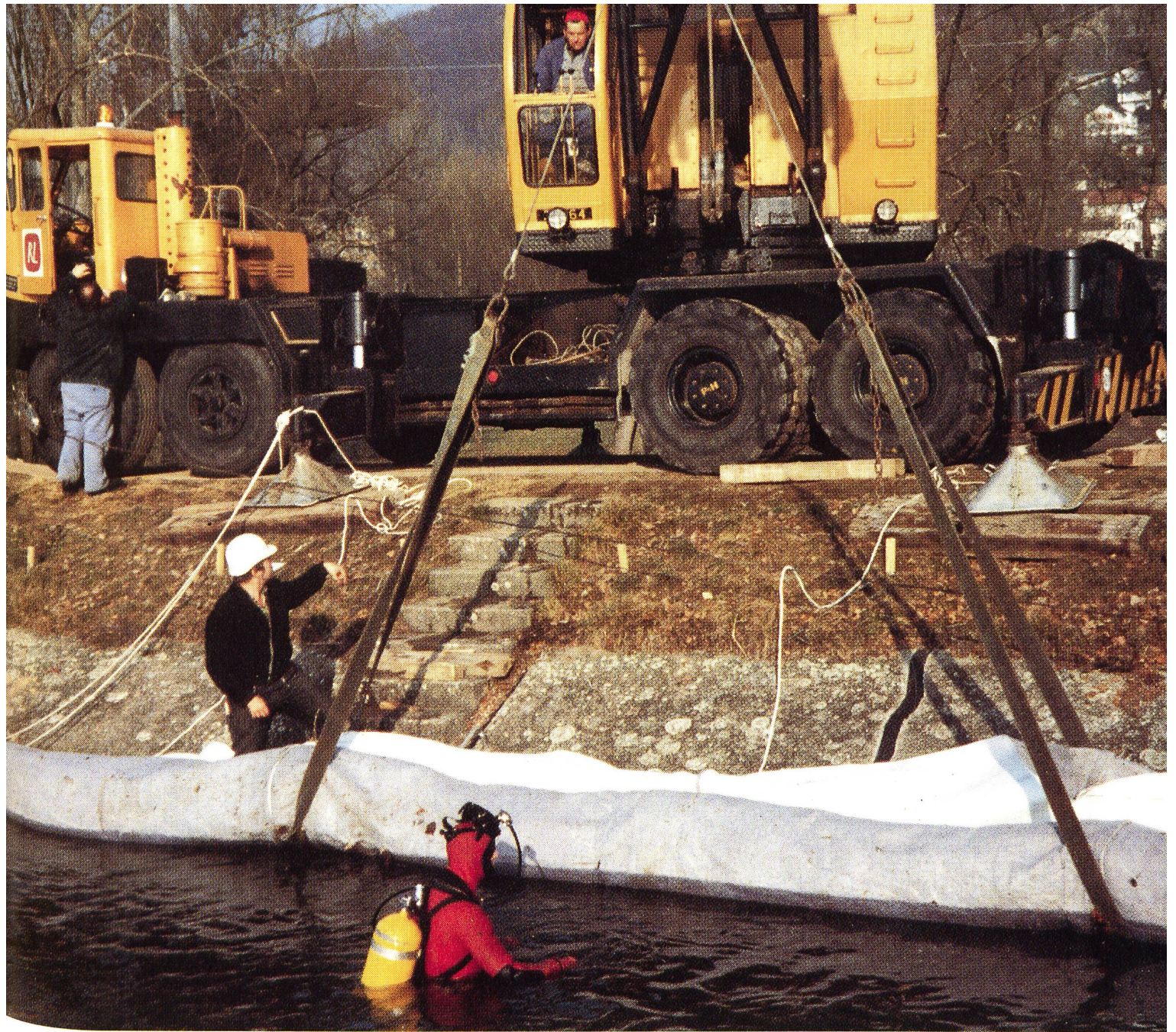
Für die Abdichtung von etwa 100 m Dammböschung im Staugebiet des Aarekraftwerks Klingnau wurden im Jahre 1984 geotextile Vliesmatten eingesetzt. Der mobile Kran senkt die noch gerollte Vliesmatte auf die Böschung ab (vergleiche Text Seite 322).
