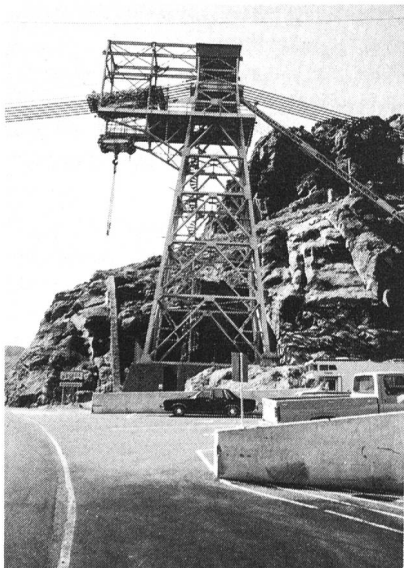
Figure 1, à gauche. Un des blondins de l'époque, à tours fixes, dessert aujourd'hui encore les deux centrales situées à la base du barrage en matériel lourd. Le chariot évolue sur 6 câbles porteurs (diamètre 10,67 cm chacun) et permet de lever ou d'abaisser des charges allant jusqu'à 135 t.
