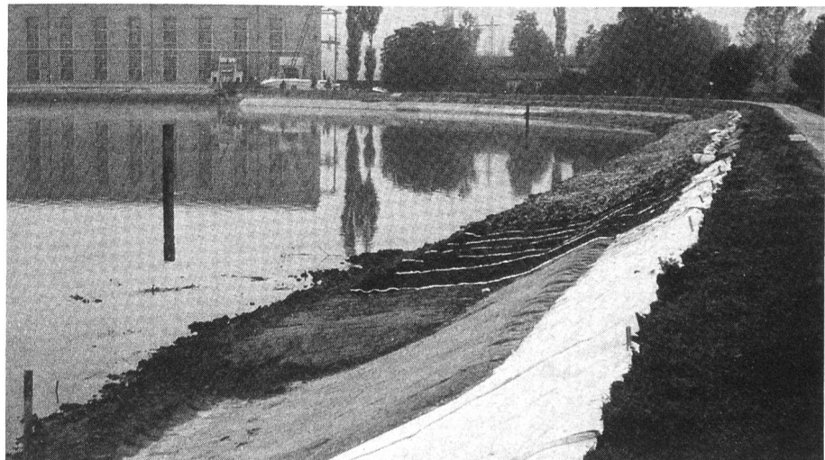
Bild 5. Schnitt (oben) und Foto (rechts) mit verschiedenen Baustadion illustrieren den Einbauvorgang der Abdichtungsauflage in der rechtsufrigen Bucht.
