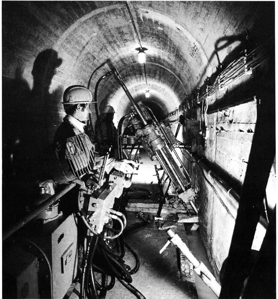
kompakte RODUR Bohr- und Injektionsanlage – Behandlung von Rissen in Massenbeton unter 90 m Wasserdruck
