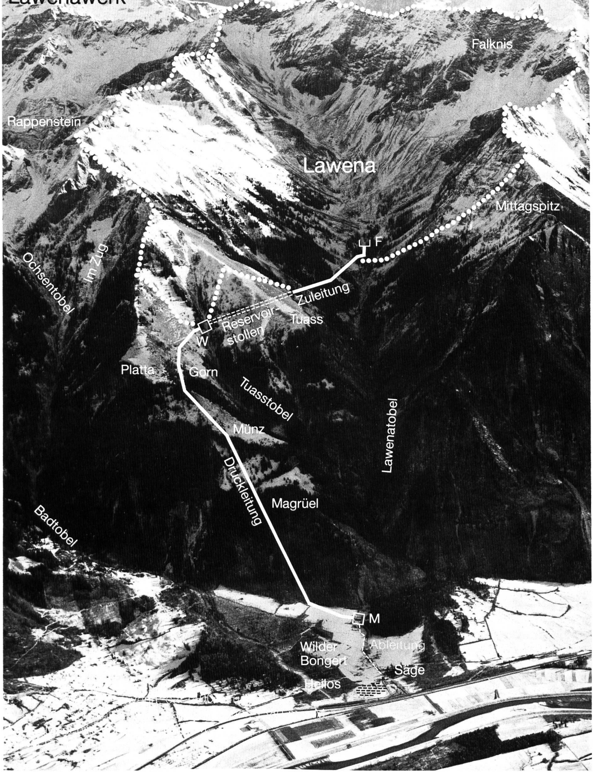
Bild 3. Übersicht über das Lawenawerk. F = Fassungen Lawena, ca. 1400 m ü.M.; W = Wasserschloss und Apparatekammer, 1380 m ü.M.; M = Maschinenhaus, 500 m ü.M.; ○○○○ Einzugsgebiet.
