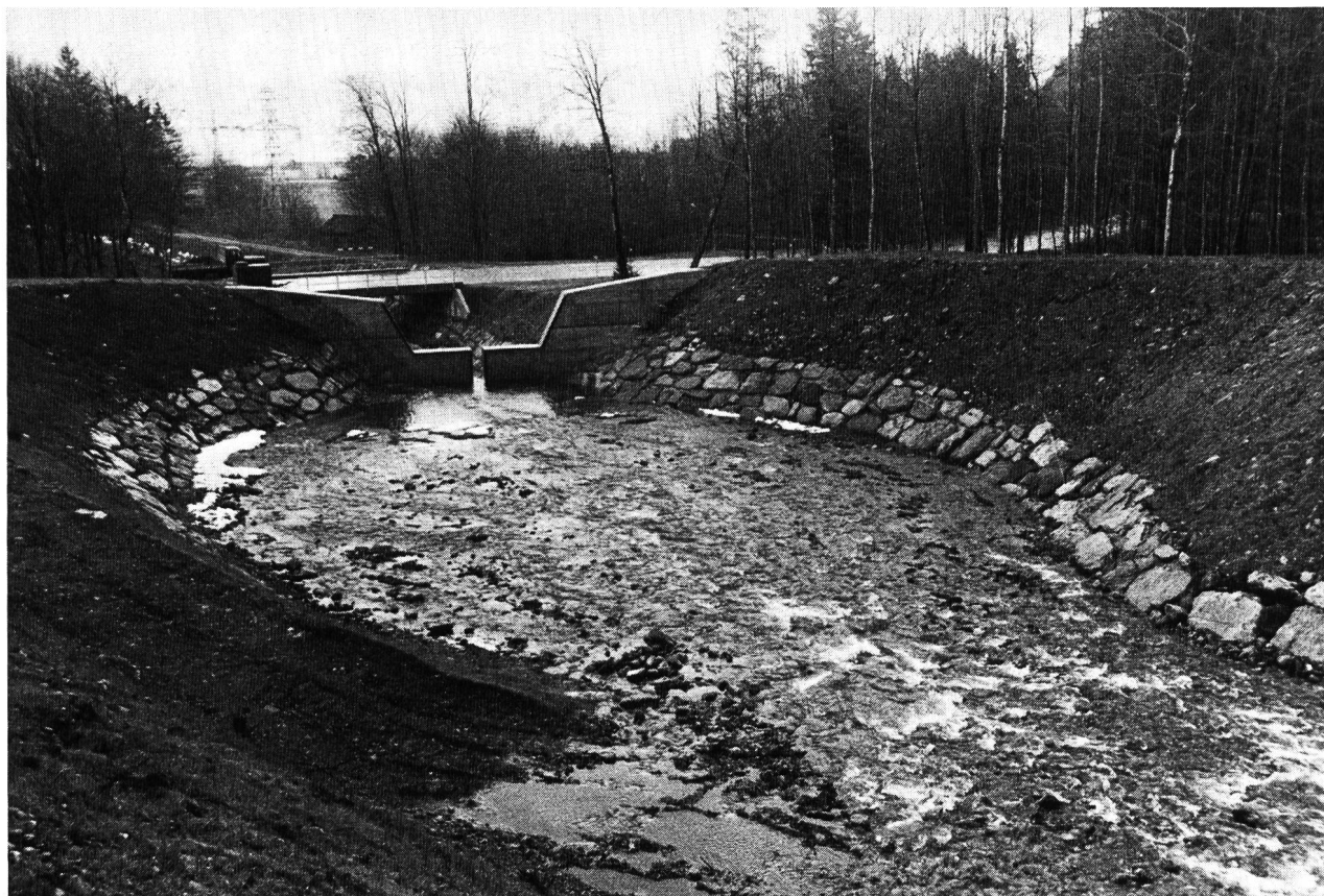
Bild 2. Geschiebeablagerungsplatz des Oltschibaches bei Meiringen.
