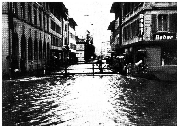
Bild 1. Langeten-Entlastungskanal durch den Ortskern von Langenthal.
