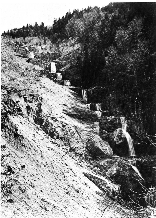
Bild 2. Der Gruonbach bei Flüelen wurde zum Schutz der Gotthardbahn seinerzeit noch mit den damaligen Mitteln verbaut. Seilbahnen, Strassen und Helikoptertransporte standen noch nicht zur Verfügung. Heute ist der ganze Hang dicht bewaldet. Die alten Verbauungen müssen schrittweise durch Betonkonstruktionen ersetzt werden. Aufnahme vom 13. April 1914. Originale im Archiv SBB, Kreis II. Forstingenieur.
