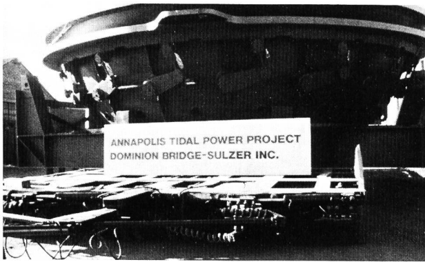
Bild 7. Eintreffen des Turbinenstators auf der Baustelle.
