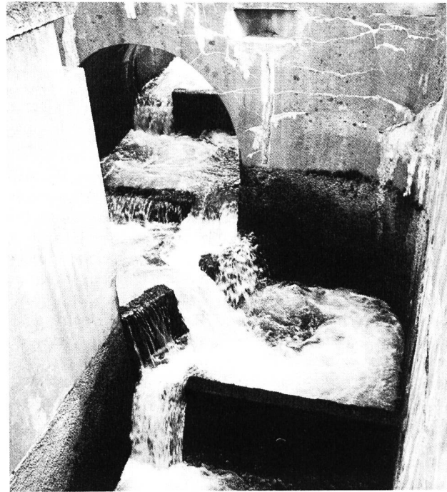
Bild 7. Kraftwerk Eglisau: Fischtreppen erhalten den Fischen trotz Stauanlagen ihren Lebensraum (aus dem Geschäftsbericht NOK, 1980/81 und Heft 3/März 1982 der «wasser, energie, luft – eau, énergie, air», 74. Jahrgang, Titelblatt).
