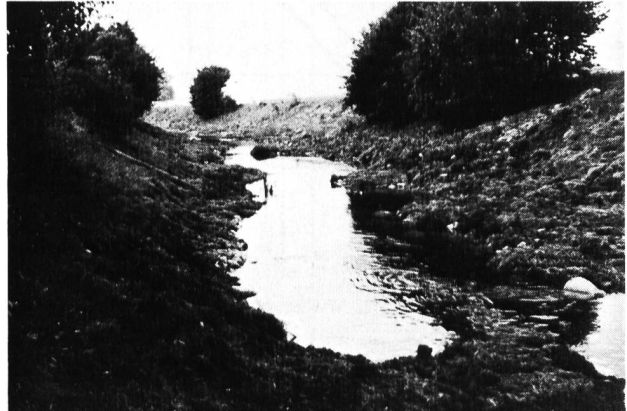
Bild 3. Umgestalteter Abschnitt des Nefbaches kurz nach Beendigung der Aushubarbeiten.
