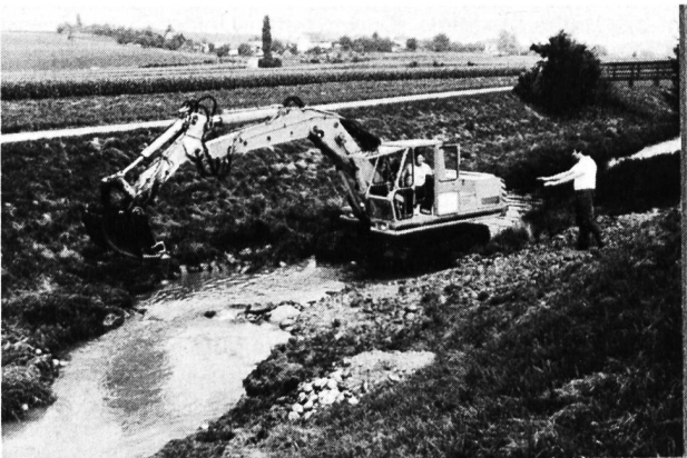
Bild 2. Revitalisierungsarbeiten am Nefbach, September 1986.
