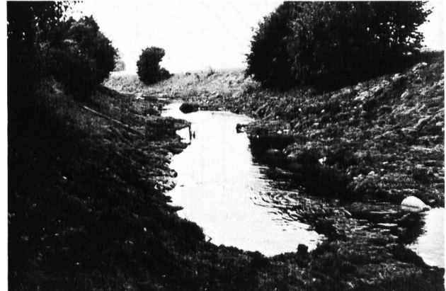
Bild 3. Umgestalteter Abschnitt des Nefbaches kurz nach Beendigung der Aushubarbeiten.
