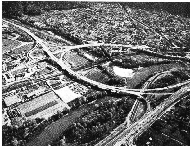
Bild 1. Gnosca e Castione – Bei der Einmündung der Moesa in den Tessin wird die Landschaft durch Betonbänder der Autobahnen und durch Bahnlinien verändert.
