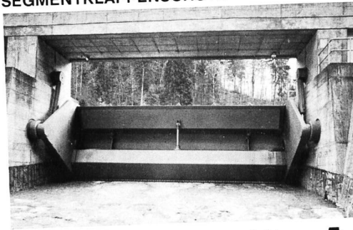
SEGMENTKLAPPENSCHÜTZ
