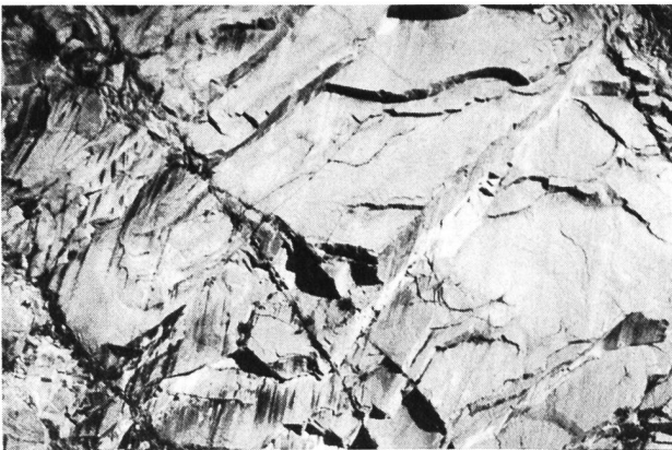
Figure 19. Décoloration du rocher dans les zones de détachement.
