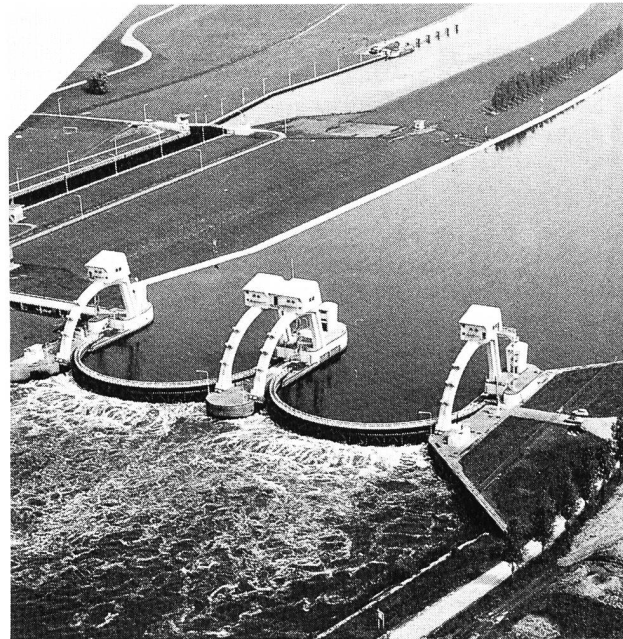
Bild 4. Strom aus dem Strom – Wasserkraftanlage Maurik am Niederrhein.
