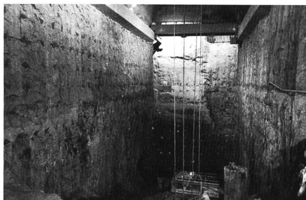
Bild 4. Kraftwerk Jostedal (1 Pelton-turbine à 275 MW). Ausbruch der Maschinenkaverne (37 000 m 3 ). Die Betonträger der Kranbahnen sind nicht abgestützt, sondern nur mit Felsanker gesichert. Die systematische Ankerung der Kavernenwände ist erforderlich, um den gefährlichen Bergschlag zu verhindern (Sprödbbruch infolge hoher Sekundärspannungen).
