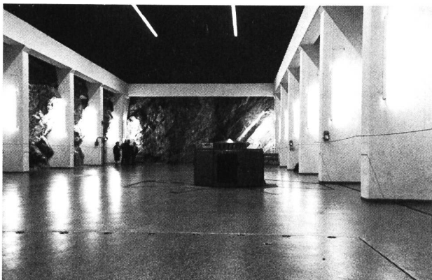
Bild 3. Kraftwerk Orkla. Maschinenkaverne Brattset (2 Pelton-turbinen à 40MW): unverkleidete Seitenwände der Maschinenhalle, mit Spritzbeton verkleidetes Gewölbe.
