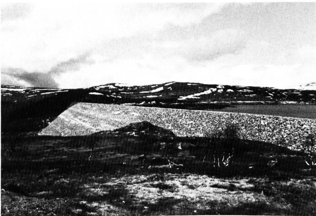
Bild 1. Kraftwerk Sy-Sima (2 Peltonsturbinen à 310 MW). Steinschüttdamm Sysen: maximale Höhe 81 m, Schüttvolumen 3,64 Mio m 3 , Nutzvolumen 400 Mio m 3 .
