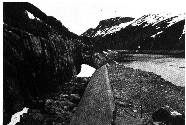
Bild 2. Kraftwerk Aurland I (450 MW). Typische Hochwasserentlastung einer norwegischen Talsperre (Speicher Viddalsvatn): seitliche Sammelrinne, betonierter Überfall, Rinne und Ablaufstollen im unverkleideten Fels.
