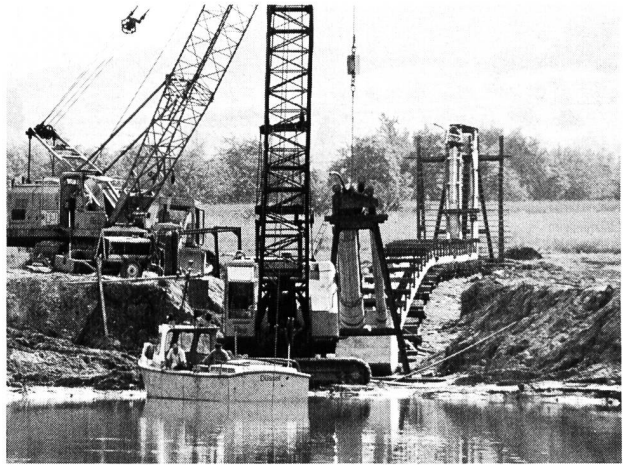
Bild 2. Der Maindüker bei der Ebertbrücke Aschaffenburg. Montage der Stahlrohre zu einem Dükerbündel; Anbringen des polypropylenbewehrten Betonmantels.
