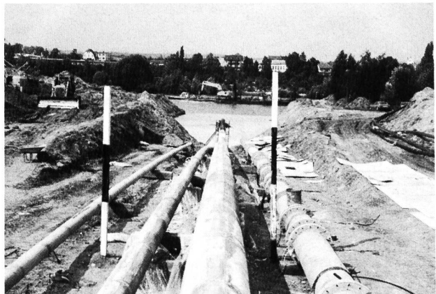
Bild 2. Der Maindüker bei der Ebertbrücke Aschaffenburg. Montage der Stahlrohre zu einem Dükerbündel; Anbringen des polypropylenbewehrten Betonmantels.
