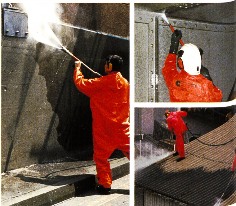
Intensive Reinigung bis zum blanken Metall Beton
